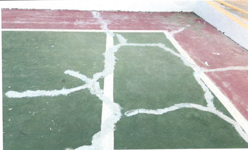
TRATAMENTO DE FISSURAS - PISO
